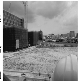
立命館大学の工事現場です。着々と
