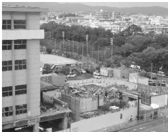
市民会館解体中
