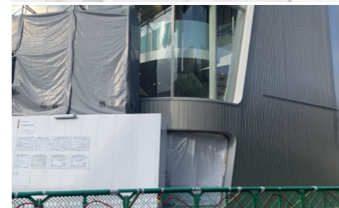
工事が進む南茨木駅
