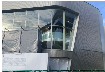
工事が進む南茨木駅ビル
