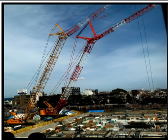
「おにくる」の工事現場
