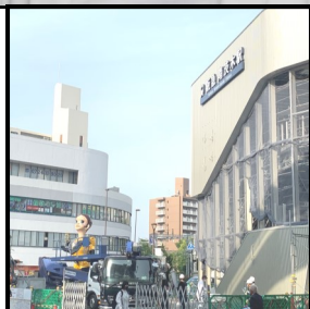
工事が進む南茨木駅舎
